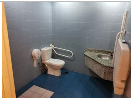
Locale wc lato arrivi
